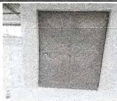
Foto 2: Colocacion de puertas.
